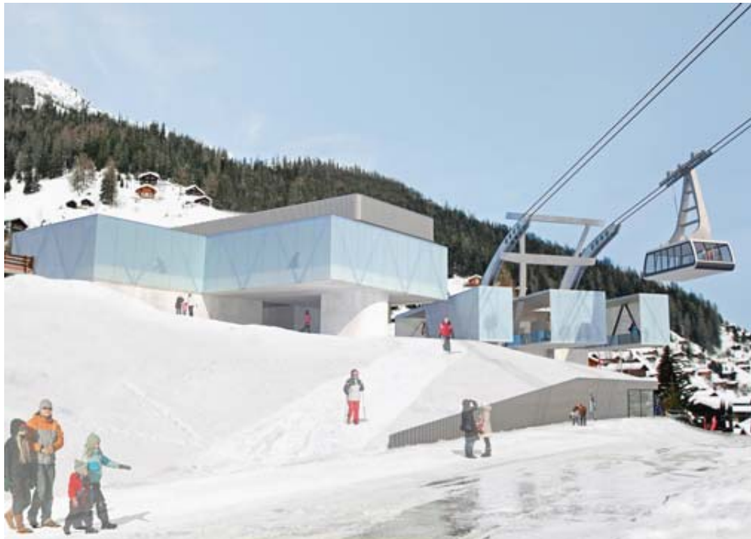
Moderne et aérienne, la future gare de départ du téléphérique qui reliera Grimentz (photomontage) à Zinal. DR
